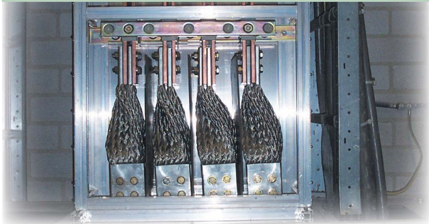
Zastosowanie złącza PBC
